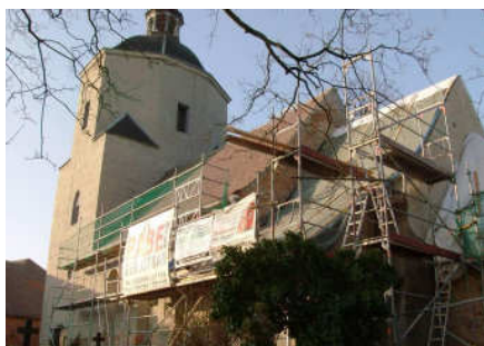
Sanierung der Kirche Dautschen
