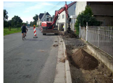
Gehwegsanierung in Rosenfeld
